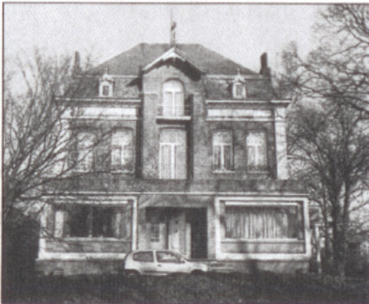
Het Lindenhof wordt vernieuwd en omgebouwd. Er worden drie appartementen in ondergebracht. Foto KOS
